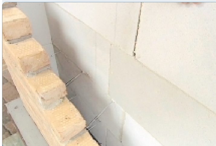
Bij nieuwbouw wordt de spouw tussen buiten- en binnenmuur meestal opgevuld met isolatiepanelen
