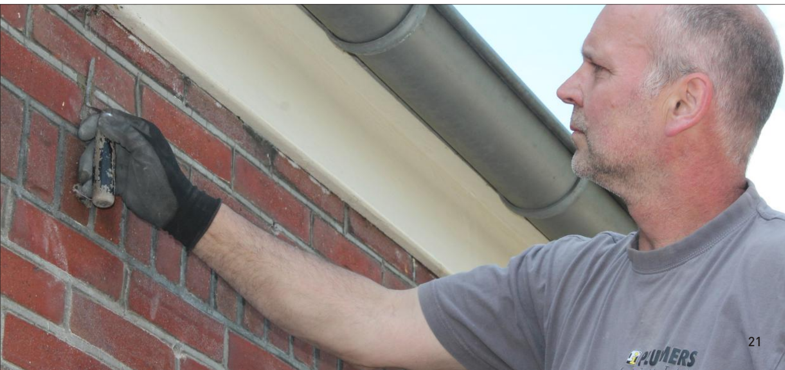
Foto: De oude voeg wordt verwijderd en vervangen door nieuw voegwerk.
