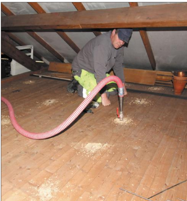
Foto: Zoldervloerisolatie met Knauf Supafil Timber Frame 033 of Greenfloc F
