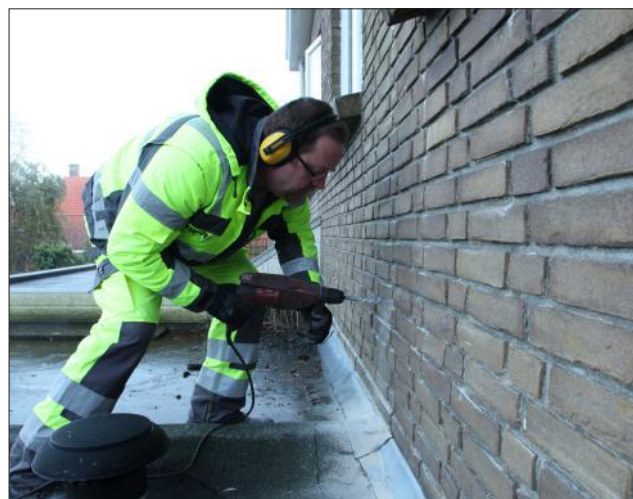
Foto: De oude voeg wordt verwijderd en vervangen door nieuw voegwerk.
