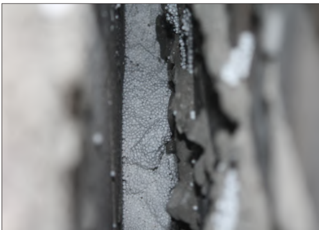
Foto: Oude spouwmuurisolatie die uit de spouw wordt verwijderd.
