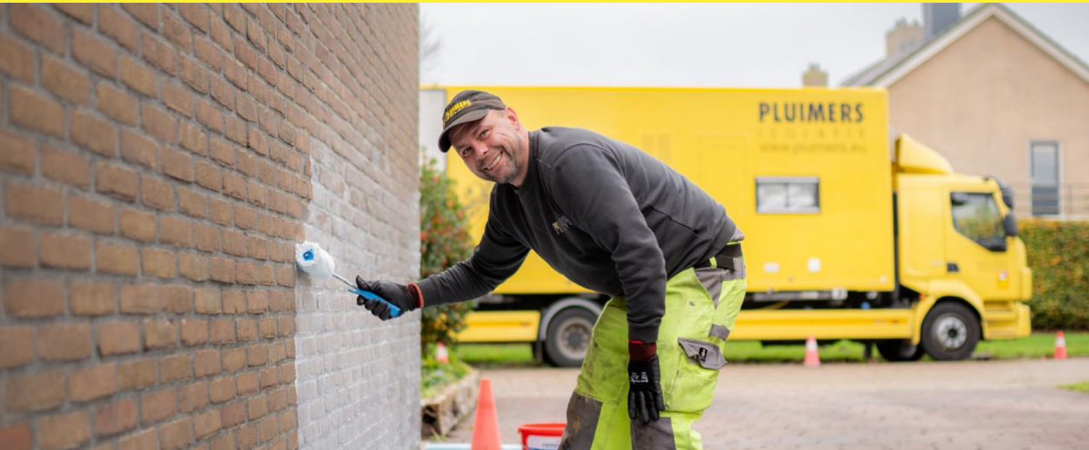
Foto: Hier ziet u hoe een gevel wordt geïmpregneerd. Binnen een dag is de crème volledig in de steen getrokken.
