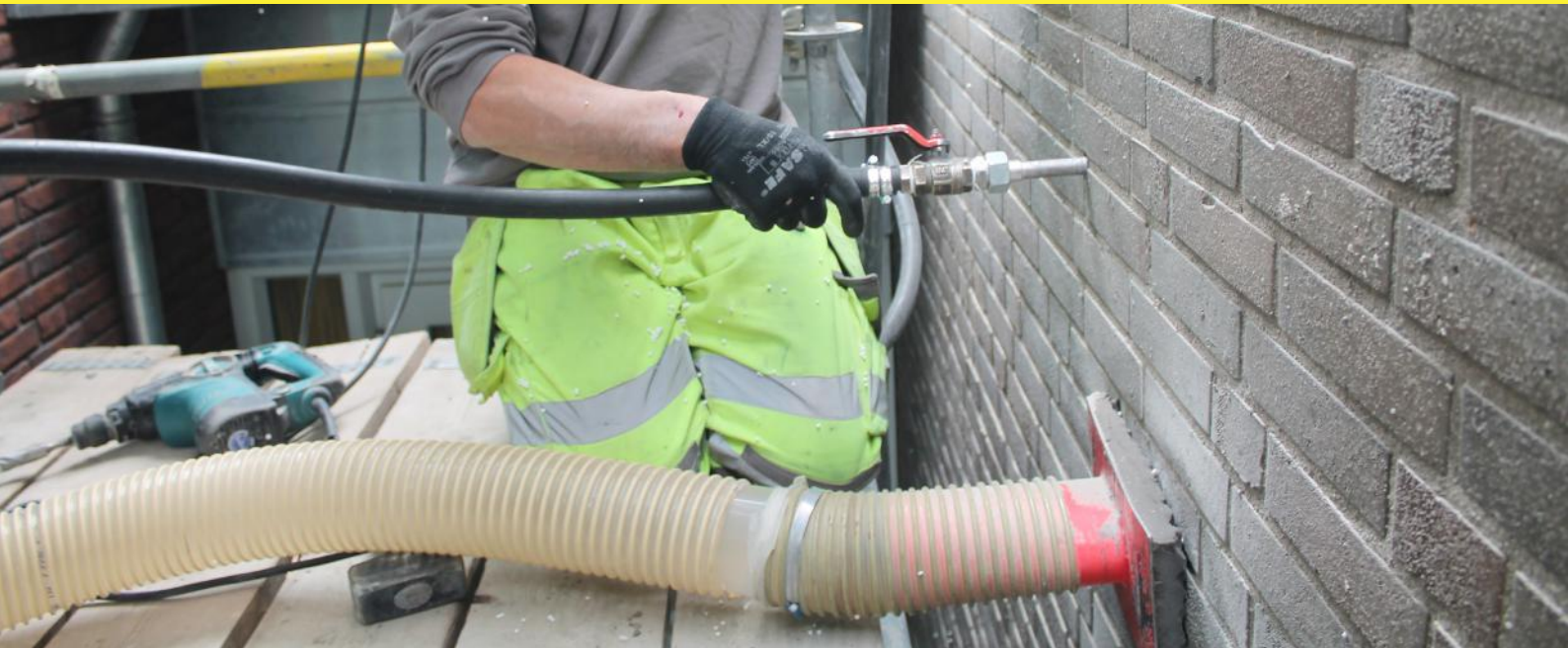
Foto: Het oude isolatiemateriaal word middels een afzuiging uit de spouwmuren gezogen.
